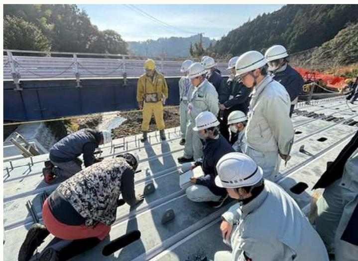
・主桁（角型鋼管）を繋ぐ作業を見学
