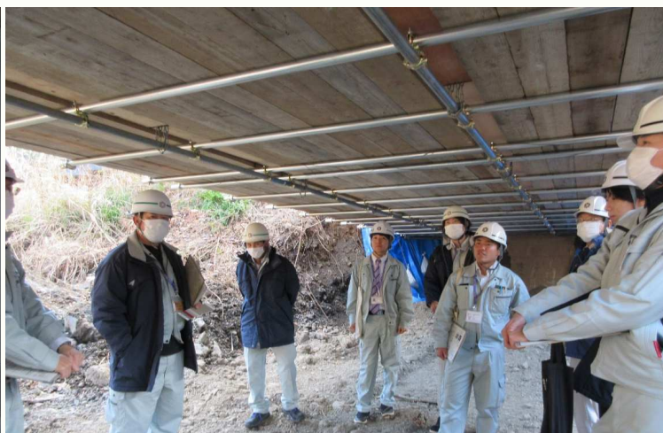
・橋梁用吊り足場工の状況を確認
