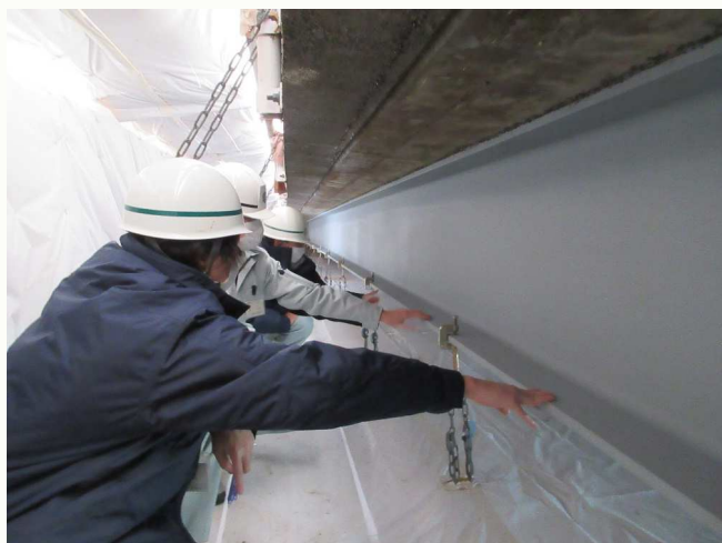
・ブラスト（研磨）と下塗り後のH鋼桁
