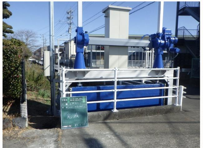
水門を電動化することにより、ボタン一つで水門の開閉ができるようになったため、管理がしやすくなります！
