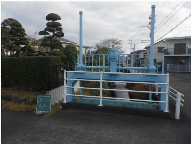
農業用水を取水するための水門です。水門の開閉は、ハンドルを回して行っていたため、管理が大変でした。
