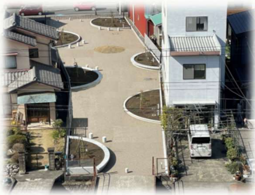
昼の様子（ドローンにより撮影）
