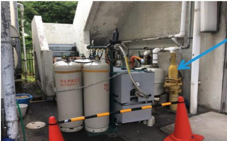
**移動式ガス発生設備(プロパン・エア式)**
