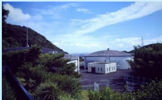
内瀬戸第1配水場
