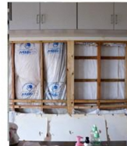
↑ 断熱材の取出し ← 水を吸った断熱材
