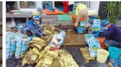
↑ 断熱材の取出し ← 水を吸った断熱材
