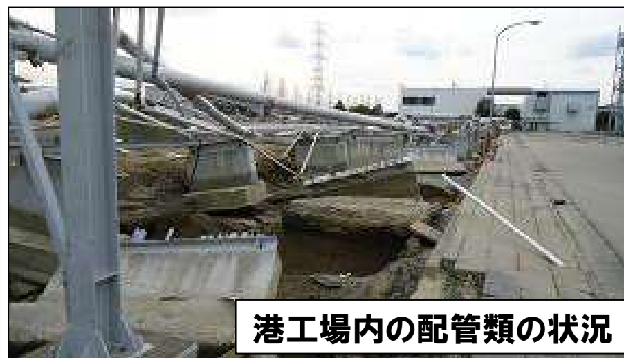
港工場内の配管類の状況
