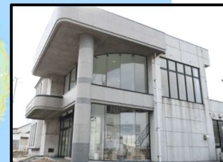
にかほガス株式会社 秋田県にかほ市
