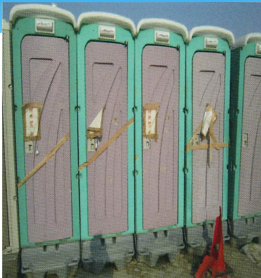
使用できない仮設トイレ
