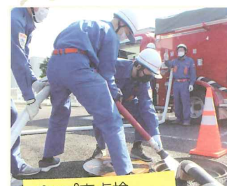
ポンプ車点検
