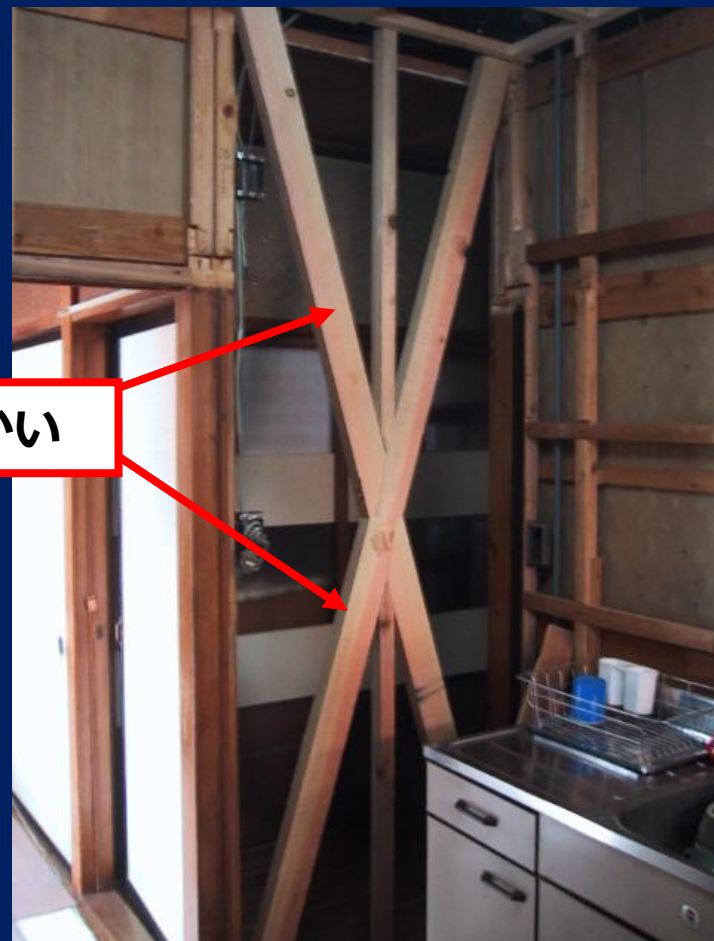
筋かいによる補強（内部）
