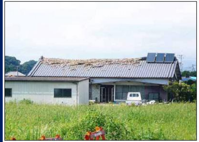
屋根瓦の損傷
