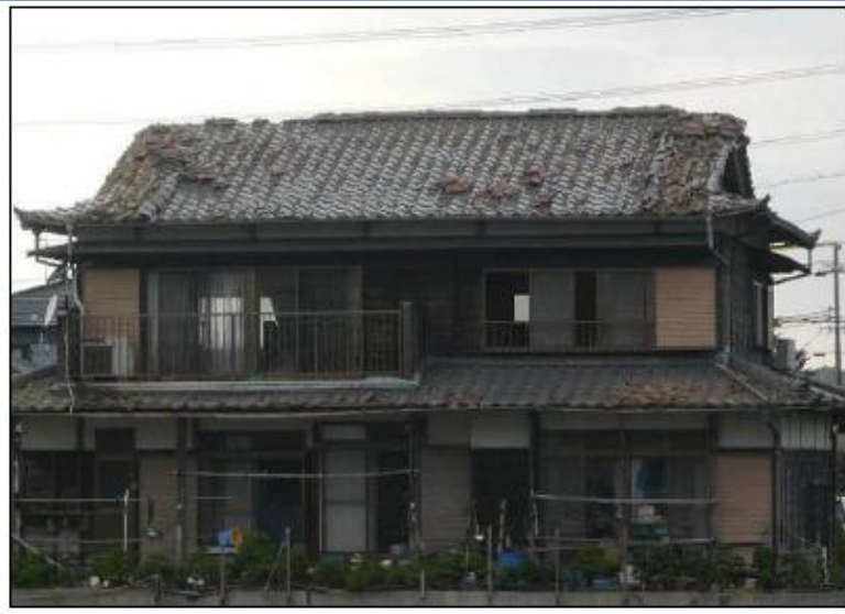
屋根瓦の損傷
