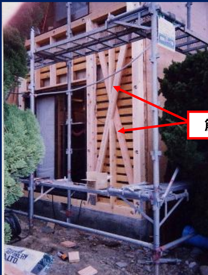
筋かいによる補強（外壁）
