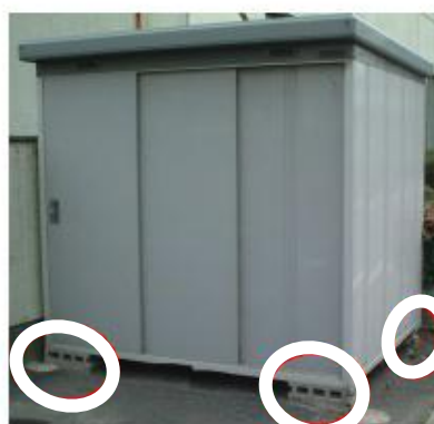
地面に置いたブロックの上に 乗せただけの簡易な物置
