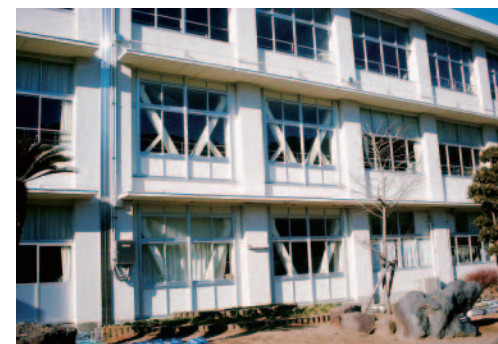
学校の耐震工事を推進。写真は平成17年度、耐震工事を行った瀬戸谷小学校
