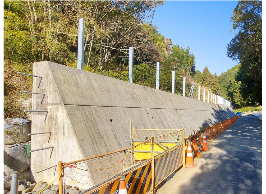
道路法面の崩土対策（茶町大谷線）
