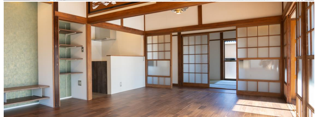
空き家のリフォーム（上：改修前/下：改修後）
