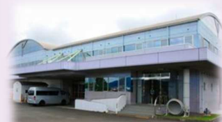
現在の中部学校給食センター
