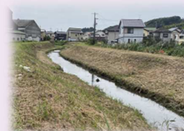
浚渫後の様子
