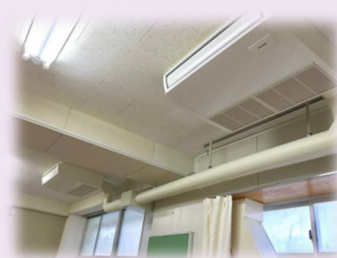
空調設備設置の様子
