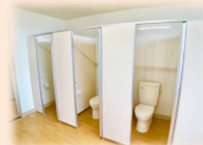
洋式化改修工事
