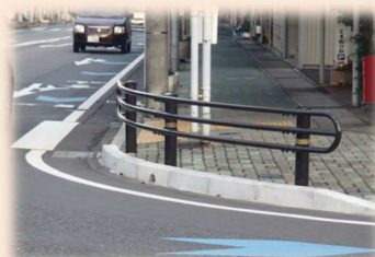
安全対策実施箇所
