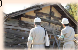
被害認定調査の様子
