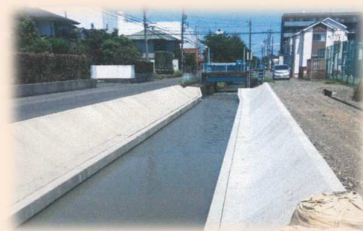
浸水対策後の様子
