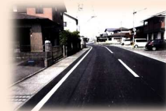
舗装のひび割れ修繕
