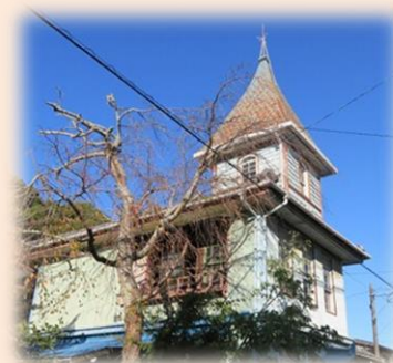
旧藤枝製茶貿易商館 明治34年（1901年）建設
