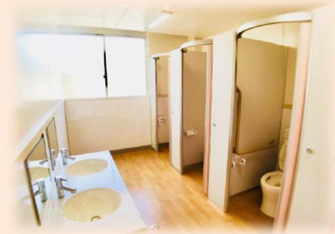
H30洋式化改修工事
