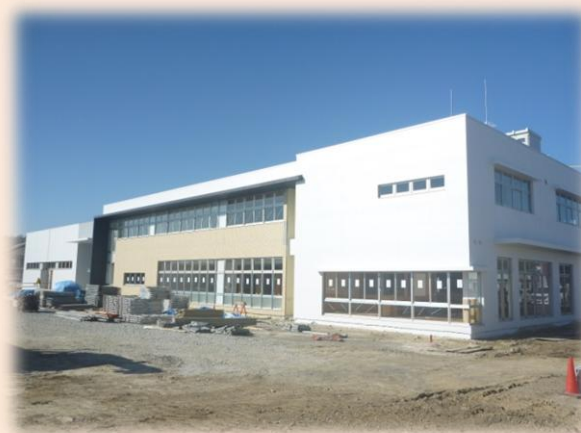
建設中の藤枝公民館
