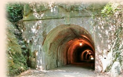
明治トンネル(宇津ノ谷峠)
