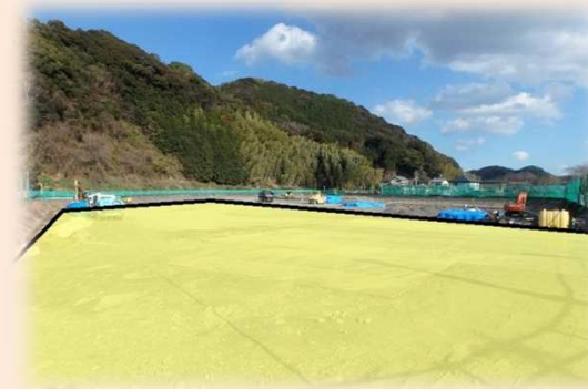
葉梨地区交流センター建設予定地
