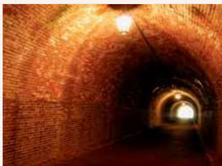
現在の明治トンネル▲
