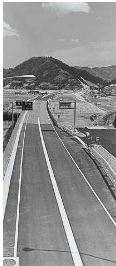
▲藤枝バイパス開通。写真は数田西IC（昭和56年）
