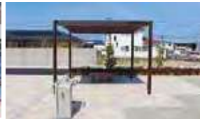
パーゴラ (休憩施設)
