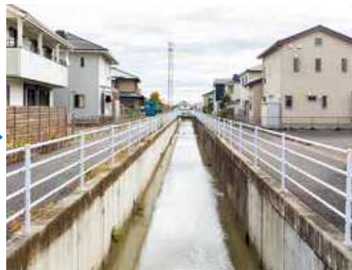
氾濫を防ぐため水路を整備。周囲には柵を設置し、安全を確保（六間支川）
