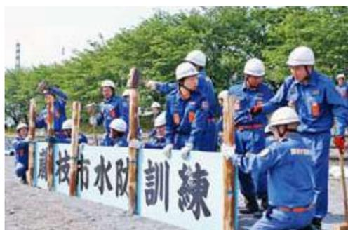
5月22日、瀬戸川のふれあい大橋下流で、水防訓練を行いました。市消防団や建設業組合、市消防署などから、約430人が参加。増水により堤防決壊のおそれがあるとの想定で訓練を行いました。これから雨の降る日が多くなり、水害が起きやすい時期になります。水防訓練は、水防機関の士気を高め、水防活動の指揮系統の確認と水防技術の向上を図るために毎年行っています。当日は、本番さながらに、訓練を実施。改良せき板工法、シート張り工法、月の輪工法、木流し工法などの水防工法を確認し、いざというときに備えました。
