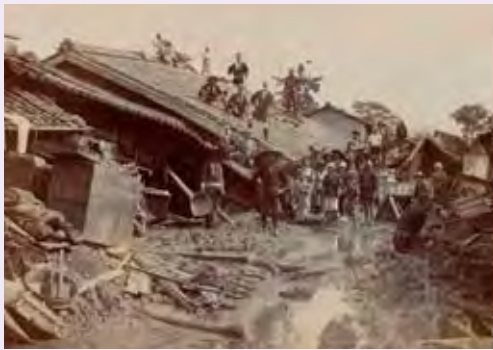
▶瀬戸川水害で倒壊した家屋
