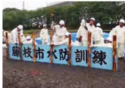
▲水の浸入を防ぐ改良せき板工法
