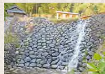
▲木和田川砂防堰堤⑥
