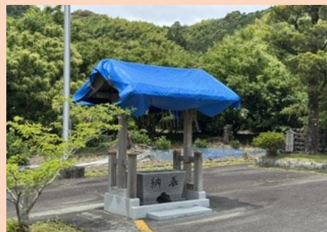
寺嶋神社の手水舎（応急処置後）
