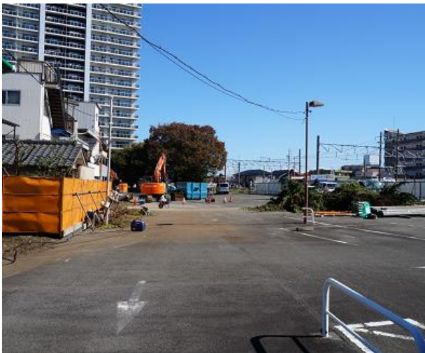
旧駅北口駐車場の西側から撮影
