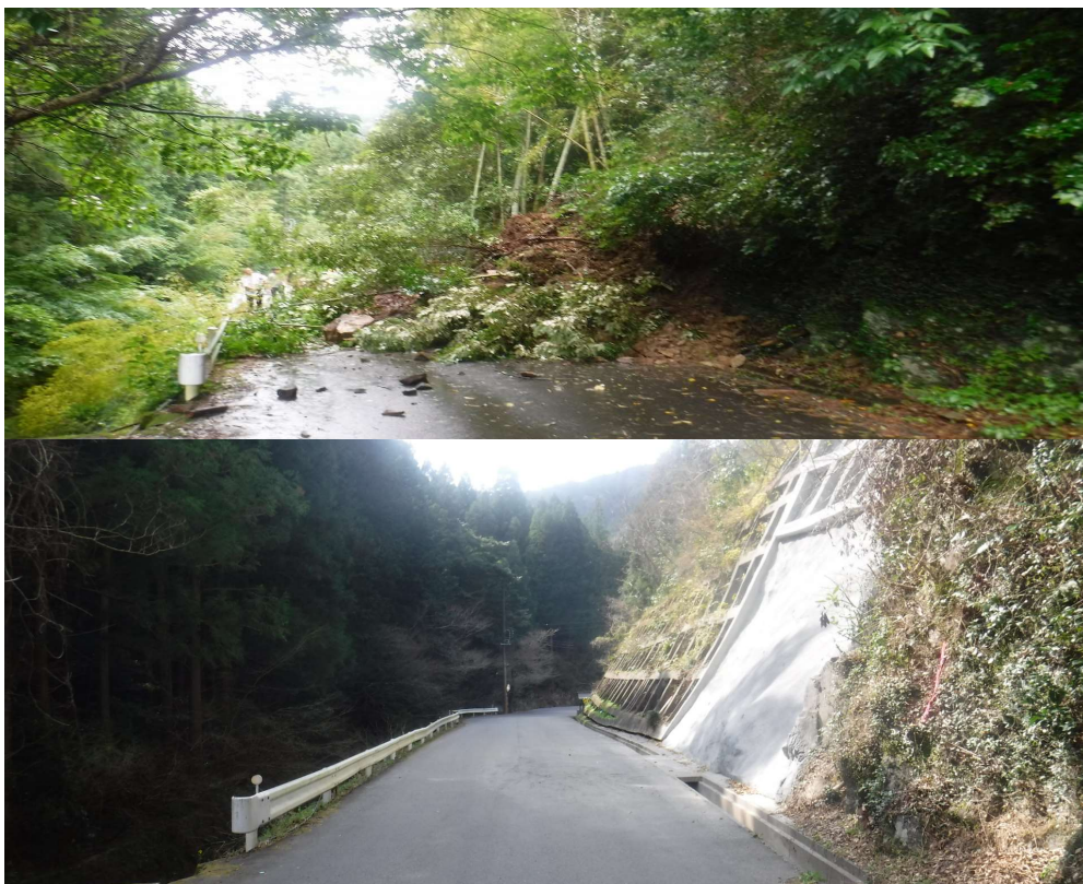
被災した法面の復旧工事（上：施工前 下：施工後）
