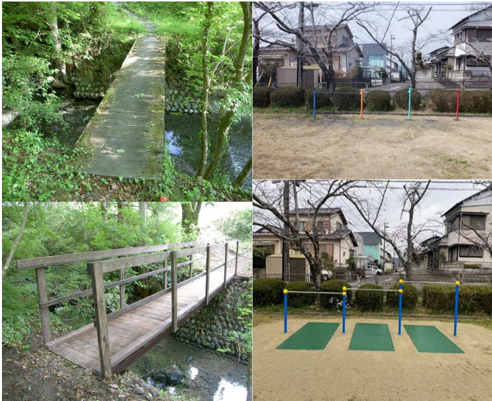
老朽化した公共施設等の改修工事（上：施工前 下：施工後）
