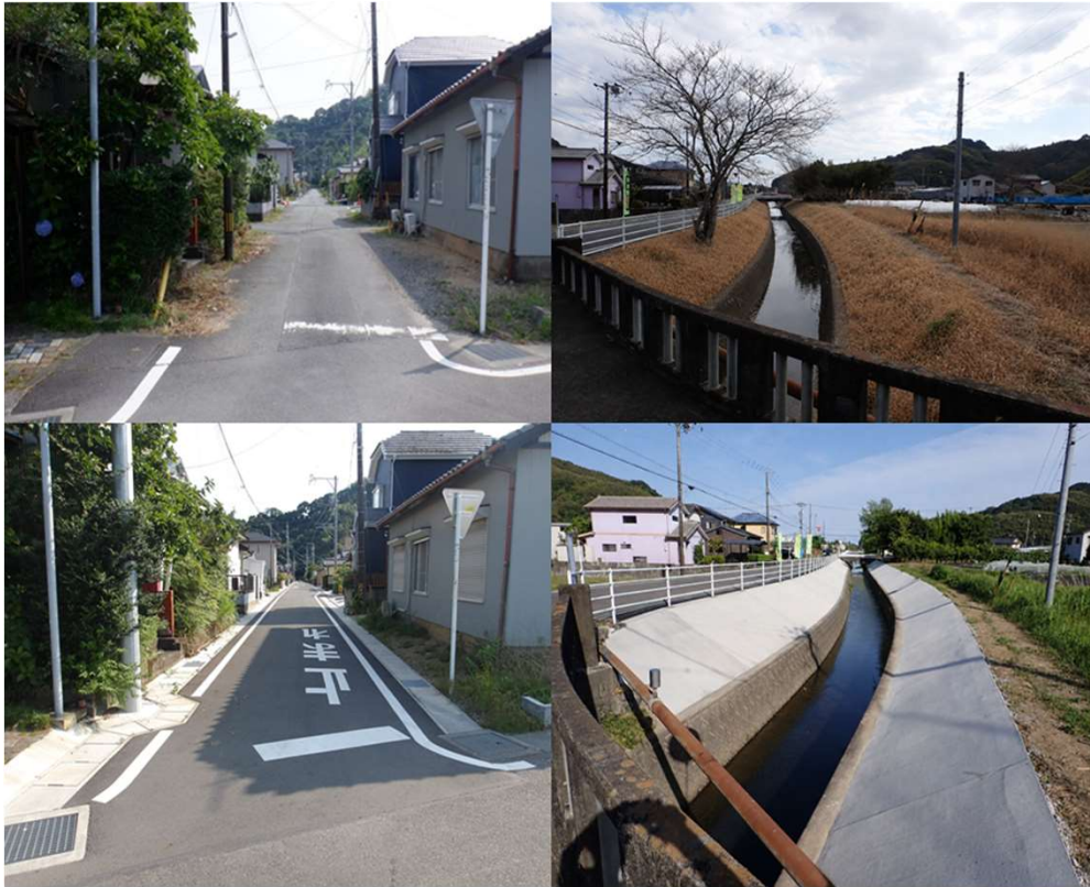
老朽化した道路・河川の改修工事（上：施工前 下：施工後）
