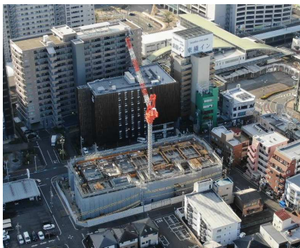
駅前一丁目9街区市街地再開発事業（建設中）
