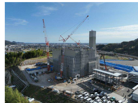
クリーンセンター志太（建設中）
