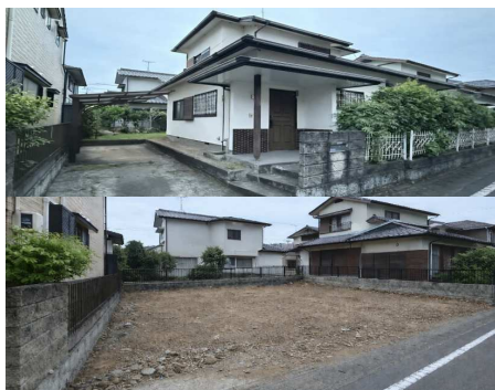
空き家の解体・撤去（上：解体前/下：解体後）
