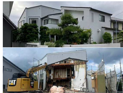
空家の解体・除去（上：解体前/下：解体中）
