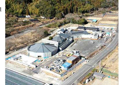
新陶芸センターと道の駅（建設中）
