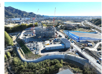
クリーンセンター（建設中）
