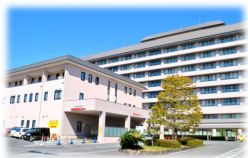
藤枝市立総合病院救命救急センター
