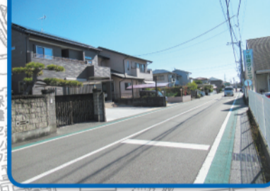
交通量が多い山崎クリニック前の歩道が狭い
