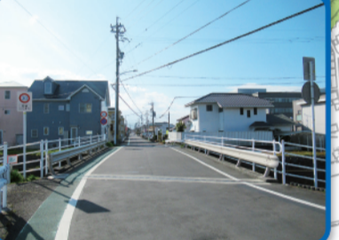
旧国1(県道381号)より車の抜け道スピードを出す車が多い
