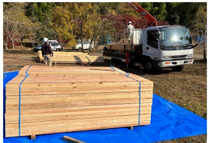
敷地見切り、コンテナ屋上デッキ用の県産材
