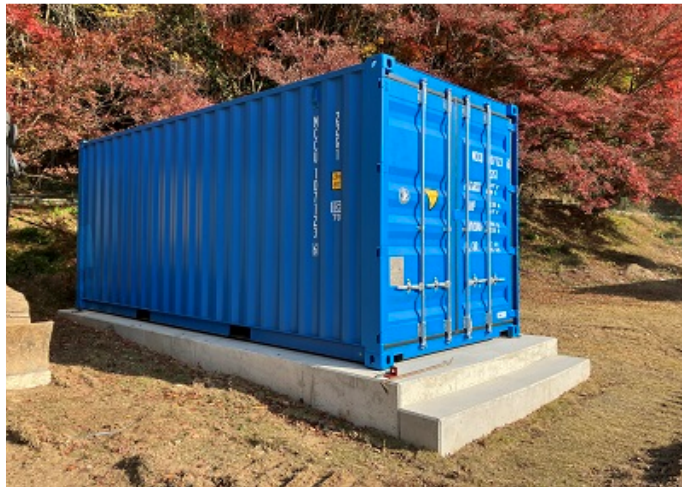
テントサイトのコンテナ設置終了
