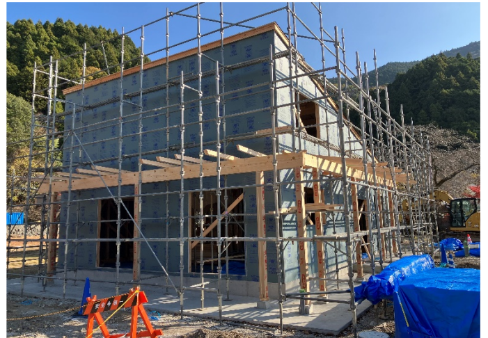
ビジターセンター(管理棟)の上棟が終了
