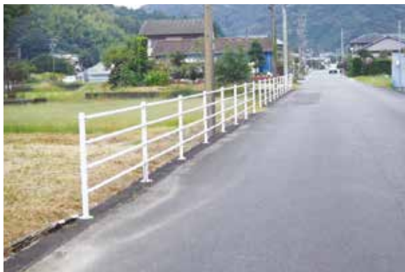
車両用防護柵が設置された道路
