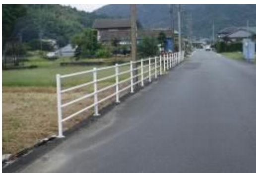
車両用防護柵が設置された道路
