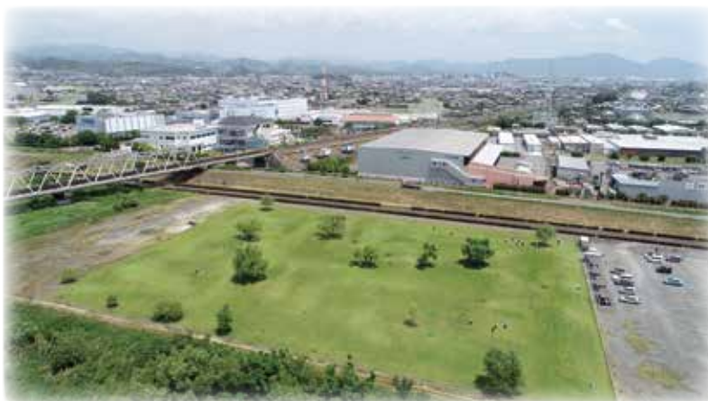
大井川河川敷グラウンドゴルフ場
