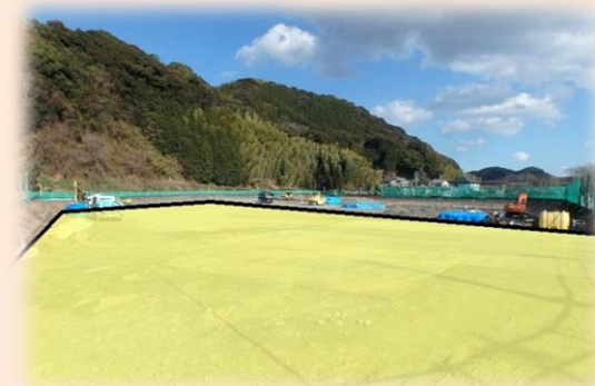
葉梨地区交流センター建設予定地
