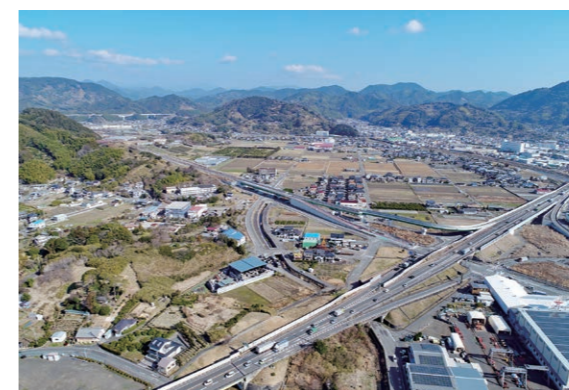
国道1号藤枝バイパス
