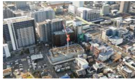
⑩ 再開発中の駅前一丁目9街区
