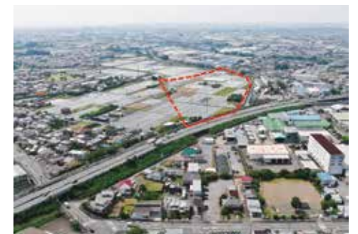
⑦ 岡部町内谷地区工業用地
