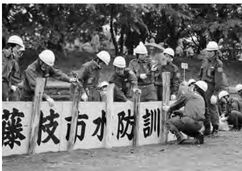
▲雨の中、改良せき板工法に取り組む参加者
