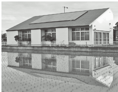
▲町内会館に設置された太陽光発電
